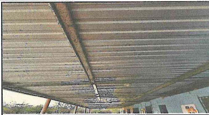
Foto 2: SUSTITUCION DE ESTRUCTURA DE SOPORTE DE METAL
