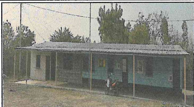
Foto1: SUSTITUCION DE LAMINA, POR LAMINA TROQUELADA
