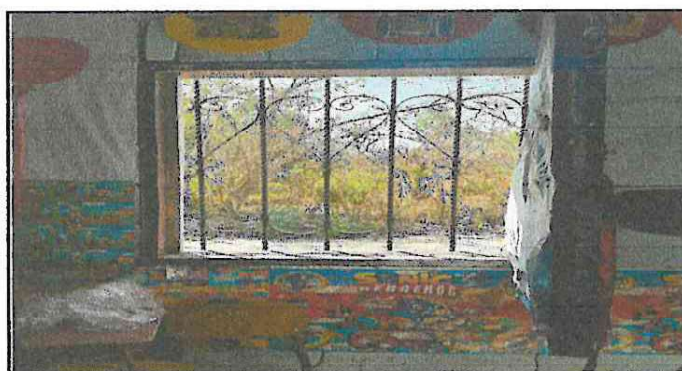
Foto 3: SUSTITUCION DE ESTRUCTURA DE METAL
