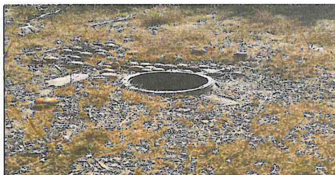
Foto 6: LIMPIEZA DE FOSASEPTICA
