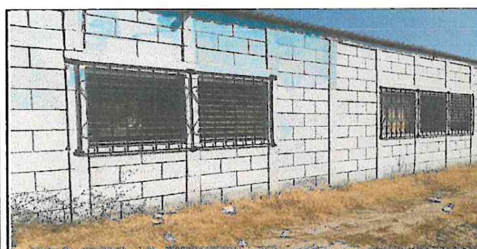
Foto 5: REPARACION DE MURO PERIMETRAL DE BLOCK
